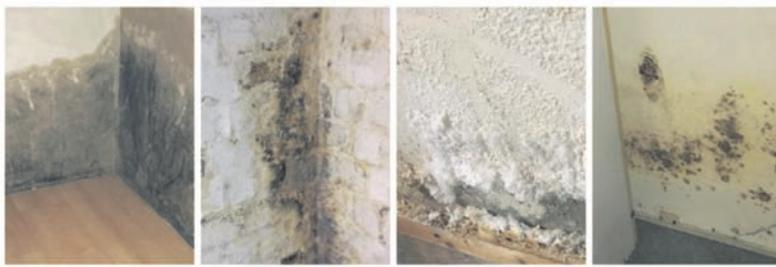
Defekte Horizontalsperre    Querdurchfeuchtung    Ausblühungen    Schimmelbefall
